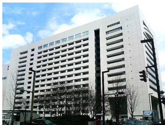
福岡市役所の地下1階に設置されました
