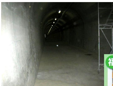
地下19mのトンネル内部通路の左側に水がためられています(左)
