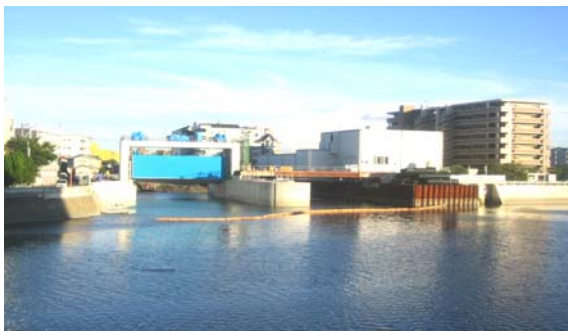
平成 19 年 8 月の工事状況
