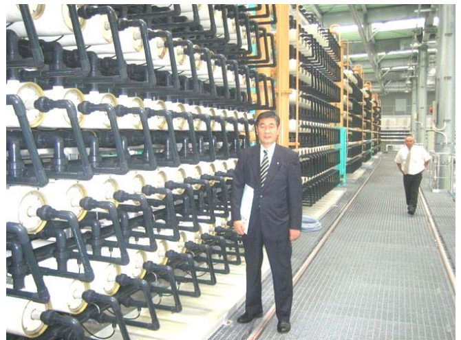
浸透膜の設置状況
